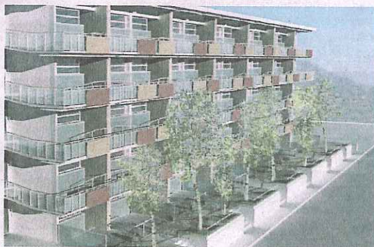
Así queda el bloque de pisos una vez apilados los contenedores
