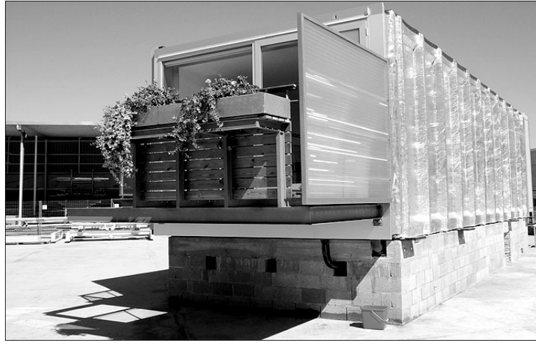
Estructura del primer habitatge pilot, que disposa d'una terrassa exterior
