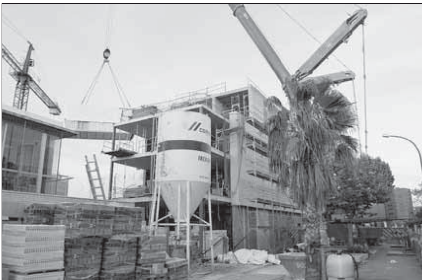
Imagen de los trabajos de instalación de los módulos, que comenzaron ayer. FOTO: PERE FERRÉ
