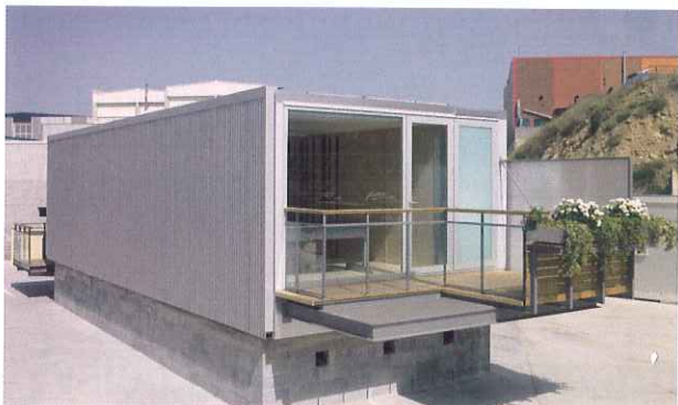
Los módulos se apilan formando edificios
