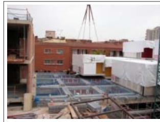
17.11.2009 | Fornós, Cristina Els treballadors guien el mòdul, per situar-lo sobre un altre al nou CAPI de Reus. Descarregar:
