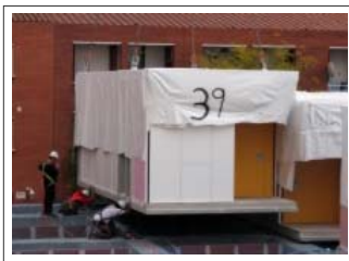
17.11.2009 | Fornós, Cristina Els treballadors guien el mòdul, per situar-lo sobre un altre al nou CAPI de Reus. Descarregar:
