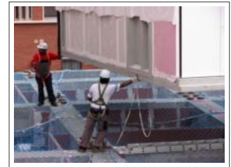
17.11.2009 | Fornós, Cristina Dos operaris guien el mòdul per situar-lo al lloc adient. Descarregar:
