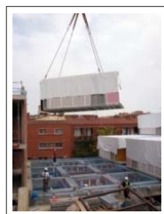
17.11.2009 | Fornós, Cristina Una grua baixa un mòdul per col·locar-lo a l'edifici del nou CAPI de Reus. Descarregar:
